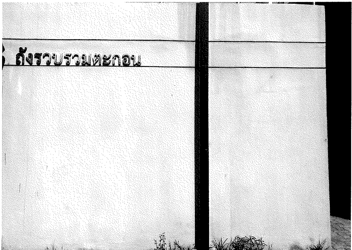
บ่อรวมรวบตะกอน
