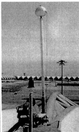
รูปที่ 8 ระบบล่อฟ้าอาคารผู้โดยสาร อาคารเทียบเครื่องบินและอาคารจอดรถฝั่งตะวันออกและตะวันตก
