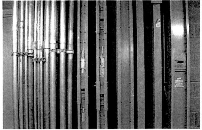
รูปที่ 6 ระบบท่อร้อยสายไฟ รางสายไฟ และ Busduct ชนิดต่างๆ ของระบบไฟฟ้าแรงดันต่ำ
