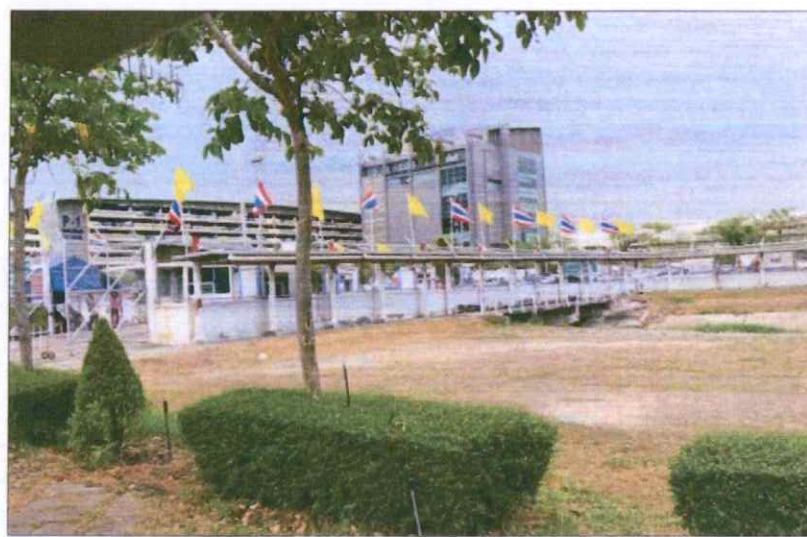
- รื้อถอนรั้วคอนกรีตบล็อก และลวดตาข่ายเหล็กตลอดแนวทางเข้า (เคลื่อนย้ายไปติดตั้งใหม่ โดยใช้เหล็กกลมเดิม) - รื้อคันทันสำเร็จรูป และรื้อโครงสร้างเสา, คาน, แป, พื้นคอนกรีตบล็อก (เคลื่อนย้ายไปติดตั้งใหม่)
