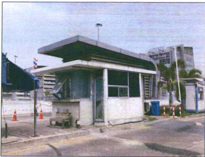
- รื้อสุขภัณฑ์, ประตู, โครงสร้างเหล็ก, กระเบื้องพื้น และกระเบื้องผนัง
