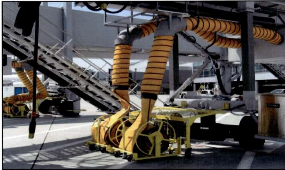
รูปที่ ก.12-4 แสดงตัวอย่างระบบปรับอากาศภาคพื้นสำหรับอากาศยาน (Pre-Condition Air : PCA)
