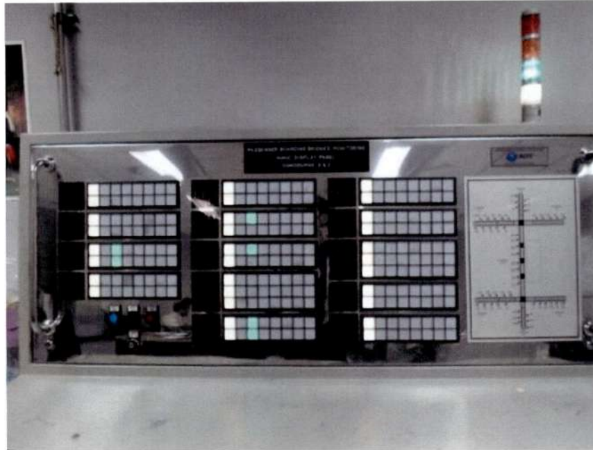
รูปที่ ก.12-2 แสดงตัวอย่างระบบแจ้งเตือนการทำงานของสะพานเทียบเครื่องบินของ ทสภ.
