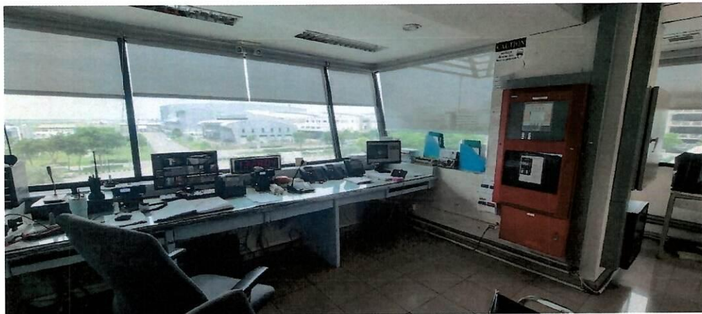
รูปที่ 2 จุดติดตั้งปุ่มกดสำหรับควบคุมการปล่อยสัญญาณไฟ ณ ห้องศูนย์รับ-ส่งข่าว สถานีดับเพลิง Main Station ท่าอากาศยานสุวรรณภูมิ
