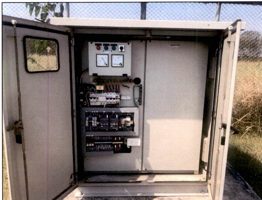
รูปที่ 7 แสดงลักษณะภายนอกและภายในของตู้ Supply Pillar
