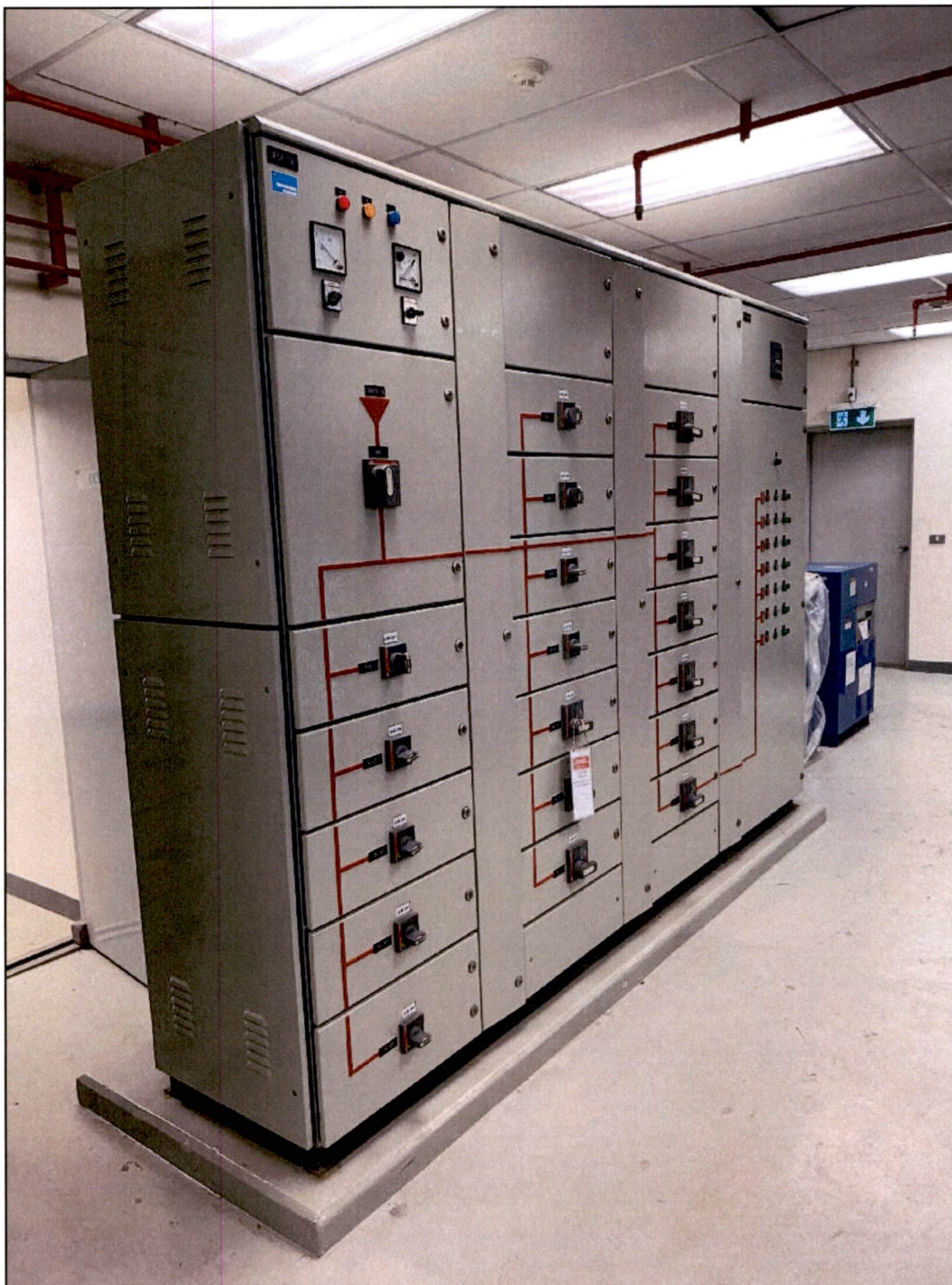
รูปที่ 1.3 แสดงลักษณะภายนอกของตู้ MDB (ชื่อตู้ UPSP)
