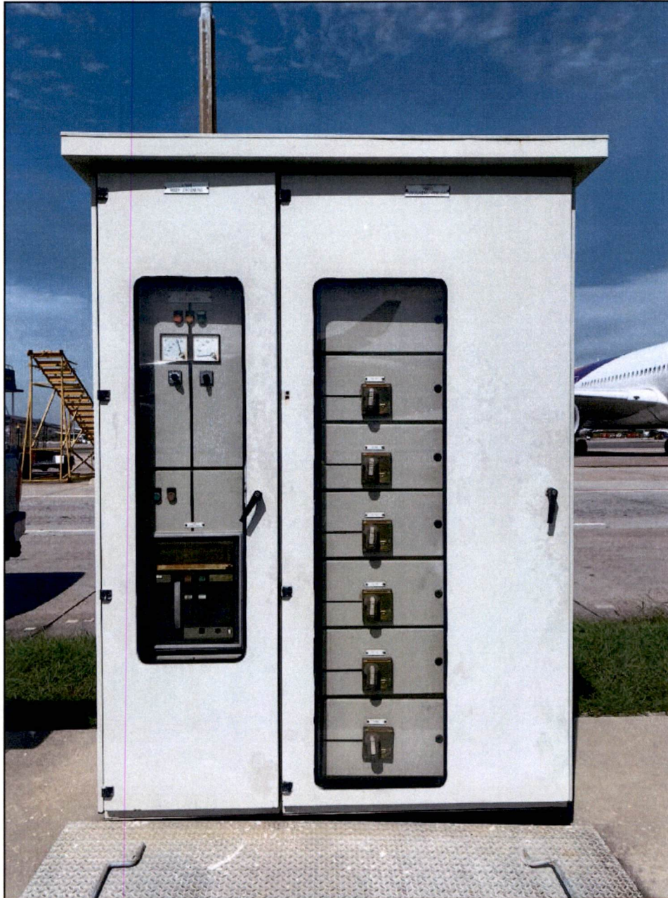
รูปที่ 2 แสดงลักษณะภายนอกของตู้ MDB (ชื่อตู้ CA, ชื่อตู้ RA)
