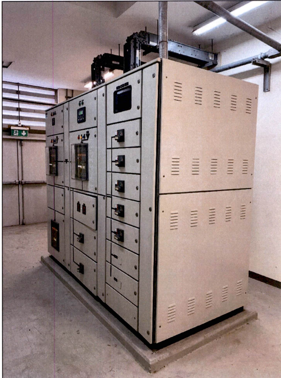
รูปที่ 1.1 แสดงลักษณะภายนอกของตู้ MDB (ชื่อตู้ MS)
