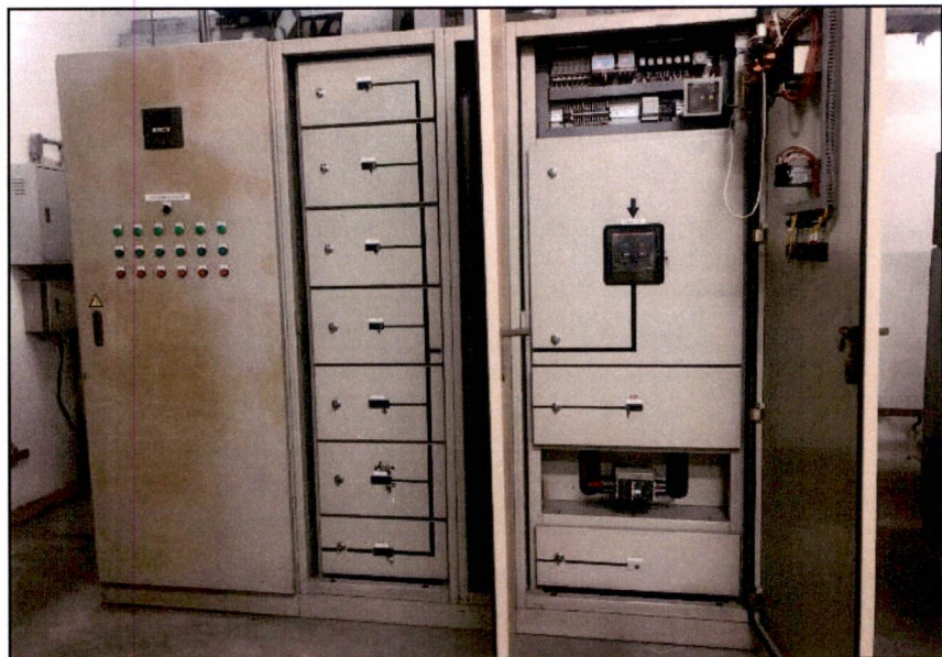
รูปที่ 5.1 แสดงลักษณะภายนอกและภายในของตู้ MDB
